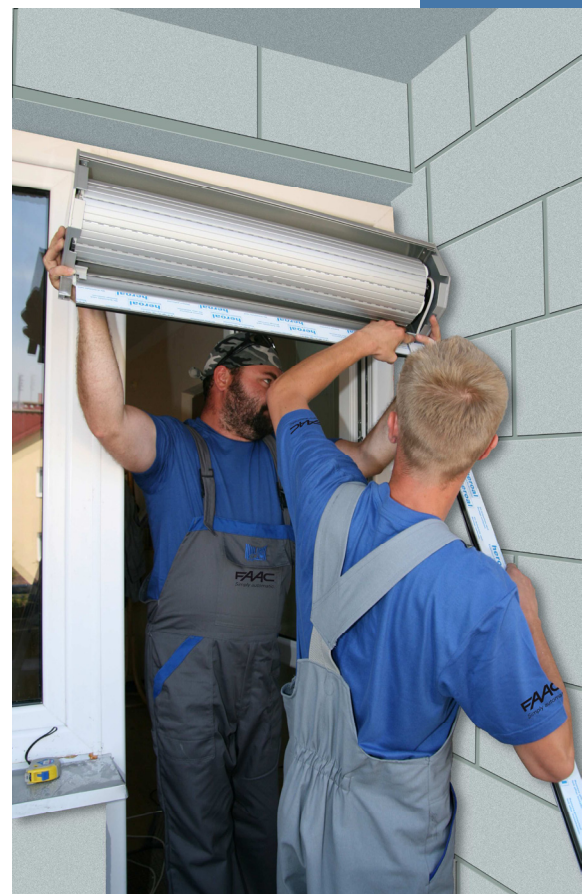
Montaż rolet z silnikiem tubowym T-mode
