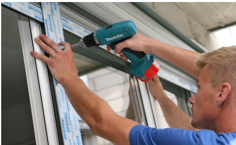
Montaż rolet z silnikiem tubowym T-mode
